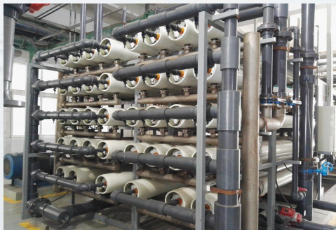
江阴热电有限公司反渗透系统
